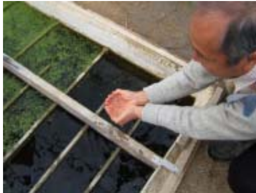
図10 温室での雑排水の浄化(放流口は手前隅)
