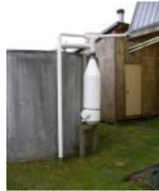
図8 雨水タンク(左)と木の葉等の除外器
